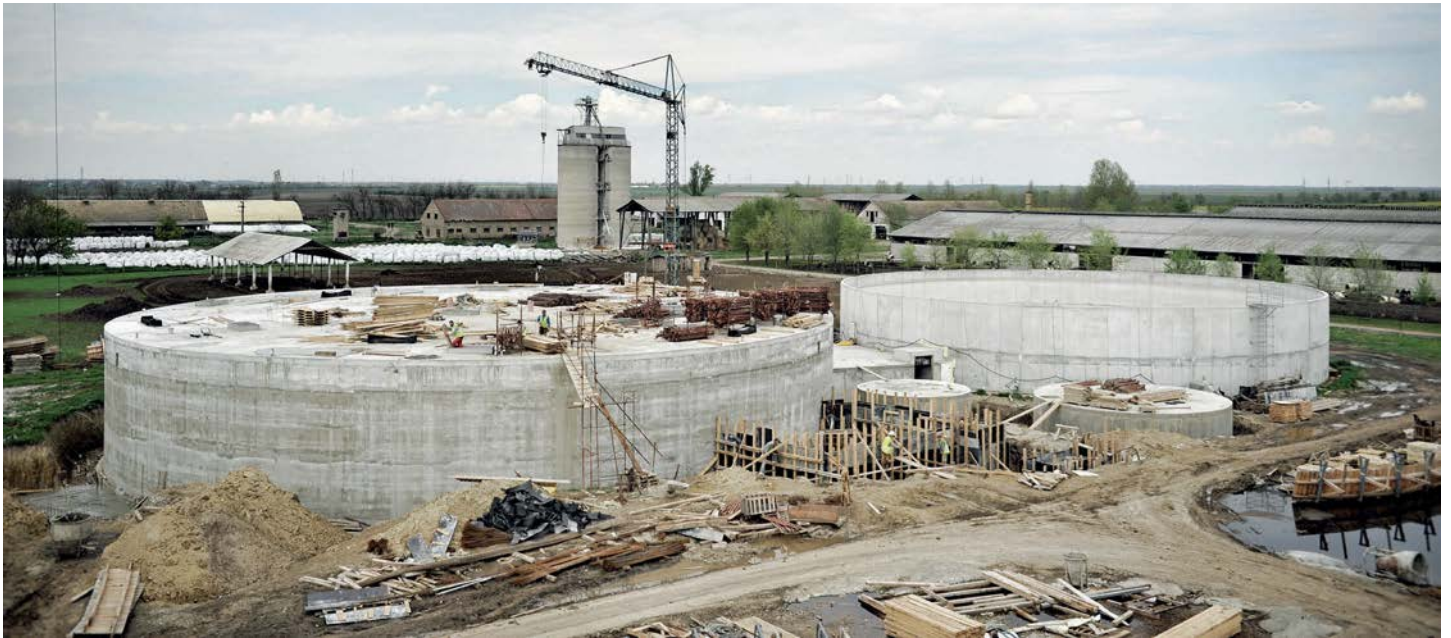
"MIROTIN SAVA KOVAČEVIĆ": Izgradnja biogasnog postrojenja
